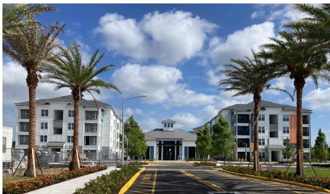
(写真右手の1棟目が竣工)
