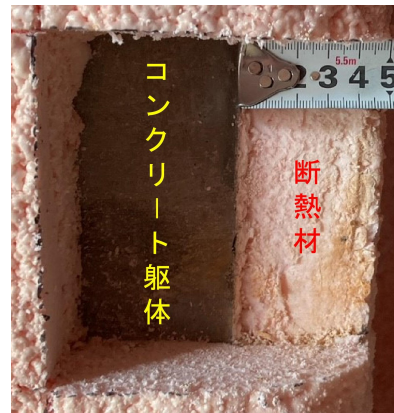
断熱材施工の断面
